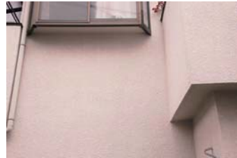
健全な外壁（ひび割れ等がない）
