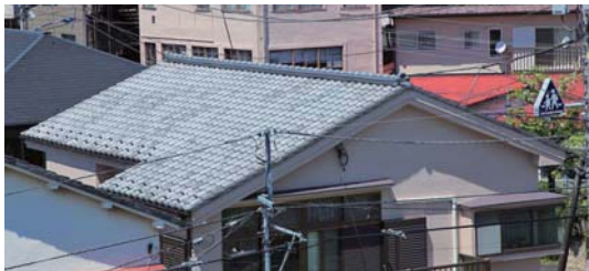
健全な瓦屋根
