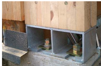
門型柱脚施工写真
