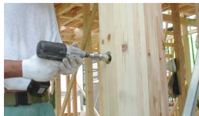
コーチボルト施工写真
