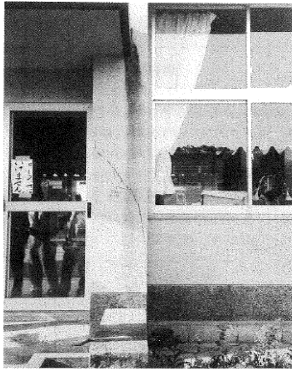
(b) 因为右侧窗下墙的影响，形成短柱，从左向右变形时柱子发生剪切裂缝
