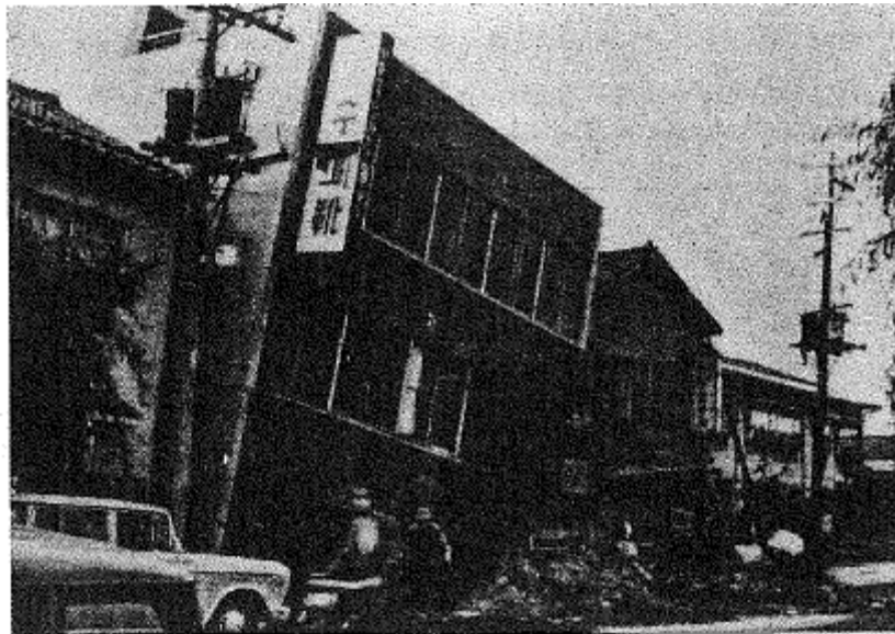
図-3 全体沈下が1mを超える被害例
